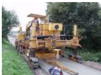
Záverečné úpravy povrchu za finišerom
