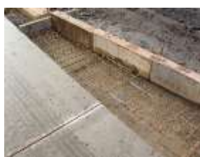
Betonáž rozšířeného pásu do debnění
