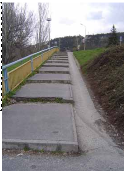
Obr.4. Žliabok na tlačenie bicykla, ul. Krajinská
