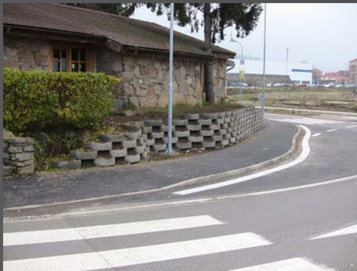
Aj na tomto 200 m úseku je možné urobiť niekoľko dosť závažných chýb. Takto to vypadá, keď sa niečo navrhuje "od stola" nedomyslené napojenie na most, alebo nedomyslené
