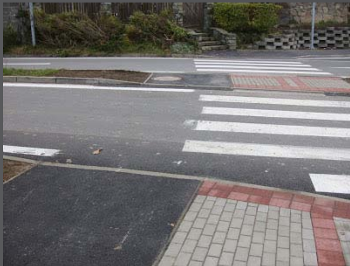
Prejazd cez cestu. Na konci zaujímavé napojenie na súčasný chodník. Tento chodník je úzky a je v zákrute.
