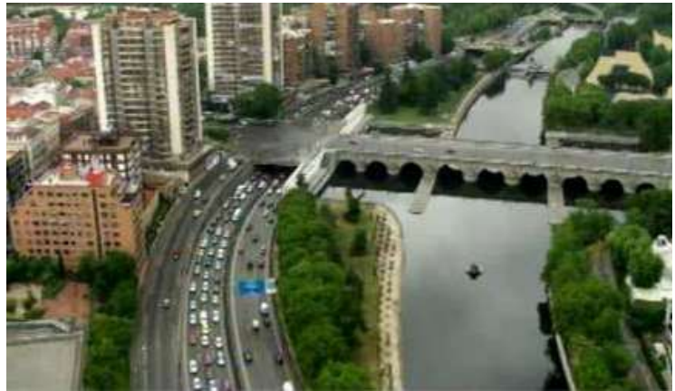
Predtým iba škaredá cesta. (Madrid rio project)
