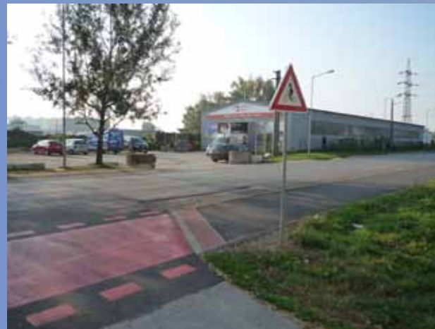
obr. 6: Nevhodne označené križovanie cesty s chodníkom označeným značkou C 12
