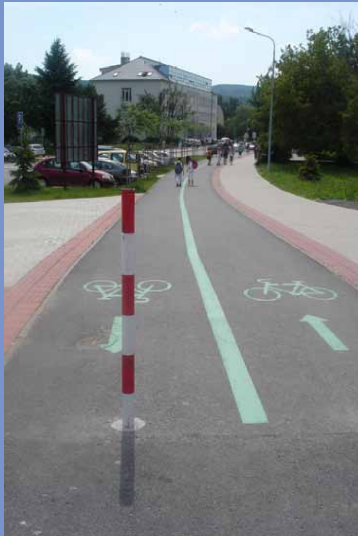
obr 1: Združený chodník realizovaný podľa platných vyhlášok (až na nevhodne umiestnený stĺpik proti vjazdu automobilov) nezabezpečí disciplinovanosť chodcov ani cyklistov.
