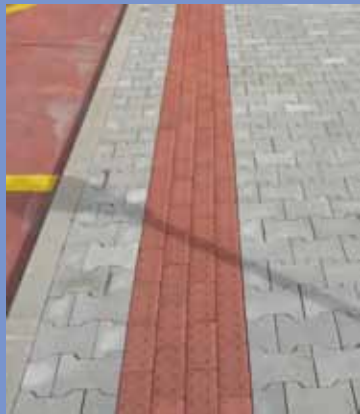
obr 2: Varovný pás na nástupišti hromadnej dopravy, šírka 400mm, reliéf s výstupkami.
