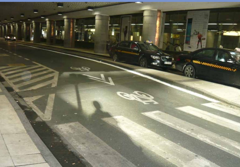
Obr: Cyklokoridor cez zástavku autobusu na Hlavnej stanici Garedu midi
