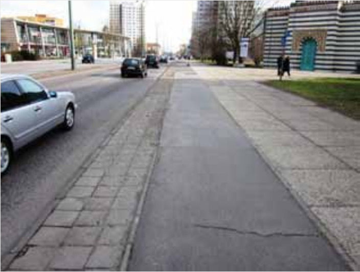
ulica s cyklocestičkou pred rekonštrukciou
