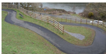
Zábradlia na cykloinfraštruktúre, str.6
